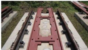
図5 逸脱防止装置の例<sup>10)</sup>
