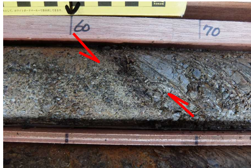
②GL-6.65m付近の粘土層 GL-5.90～6.65mは脆弱な粘土層が分布し、GL-6.65mは下端となる。40° の面構造が認められる。
